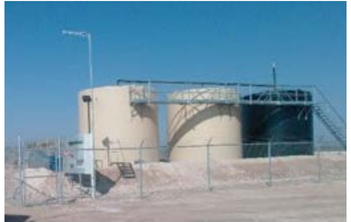
Localidad con pozo de inyección
